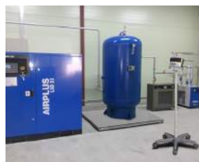
플랜트 업체 플랫폼 저울 설치사례
